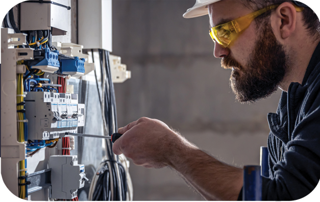
○ صيانة لجميع أعمال الالكتروميكانيكال
